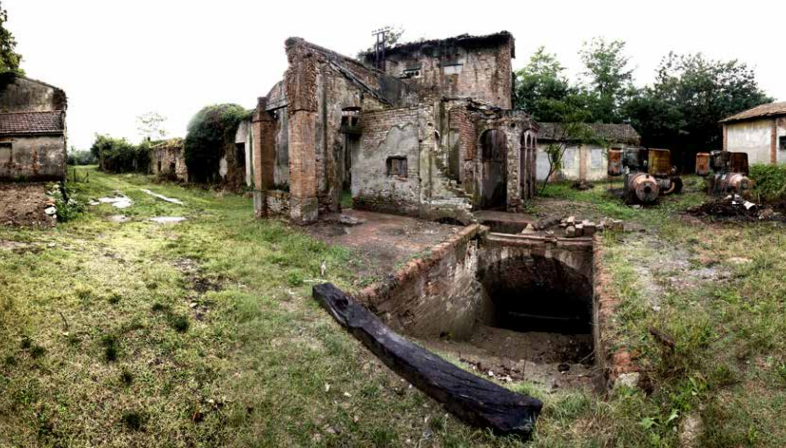
Fig. 11 – In primo piano l'ingresso della discenderia, subito dietro la "buca" che dà accesso alla scala operai, ancora dietro la loggetta accanto alla lampisteria (foto P. Lucci).
