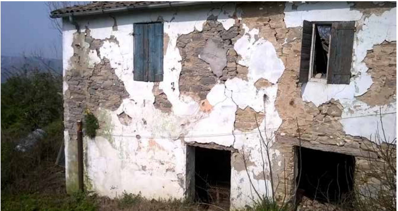
Fig. 2 – Edilizia rurale storica presso il castello di Polenta (Bertinoro), costruita con gesso risedimentato (foto S. Piastra).
