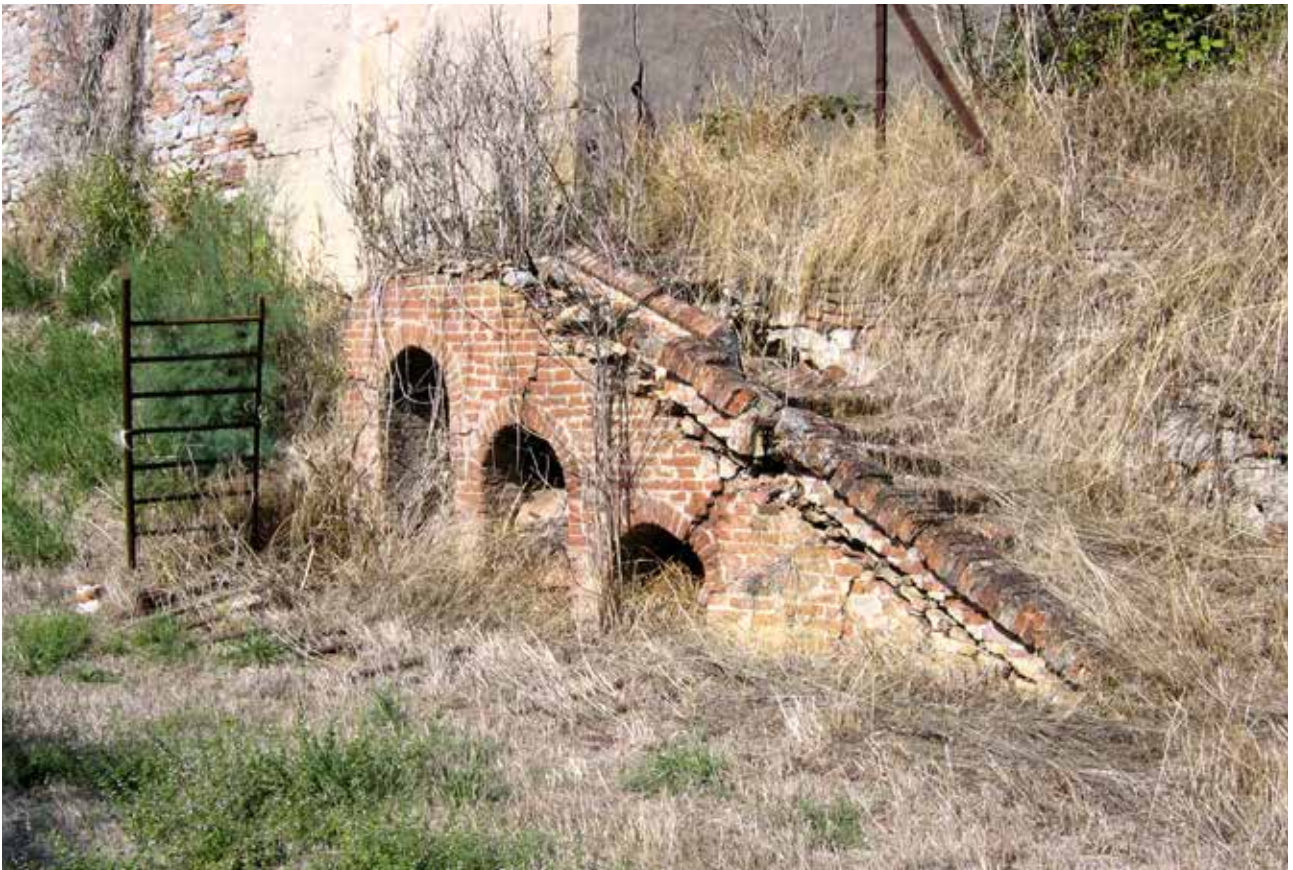
Fig. 10 – Formignano. Scala centrale, 2005 (Archivio SRSRM).
