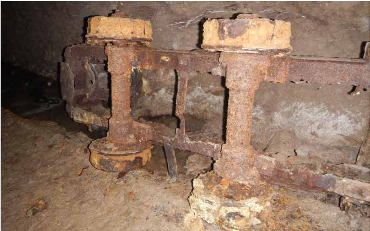
Fig. 27 – Supporto di carrello rovesciato nella galleria con binari (foto G. Rossi).
