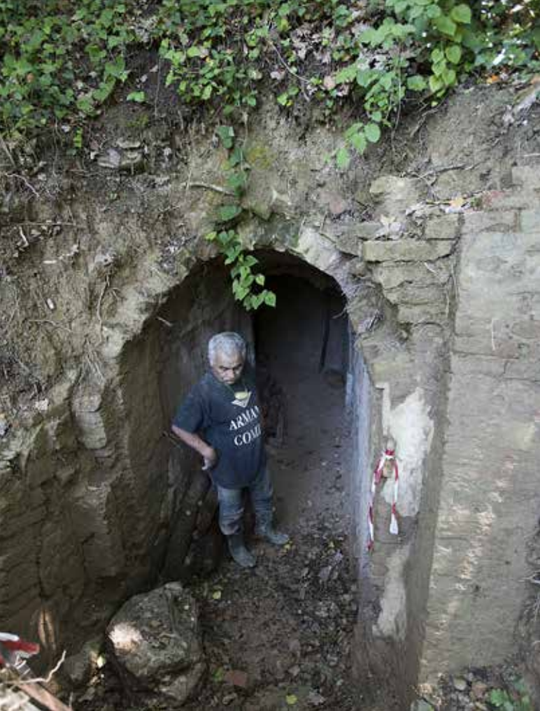
Fig. 32 – Ingresso della galleria di servizio del Tiro Confine dopo lo scavo (foto G. Belvederi).
