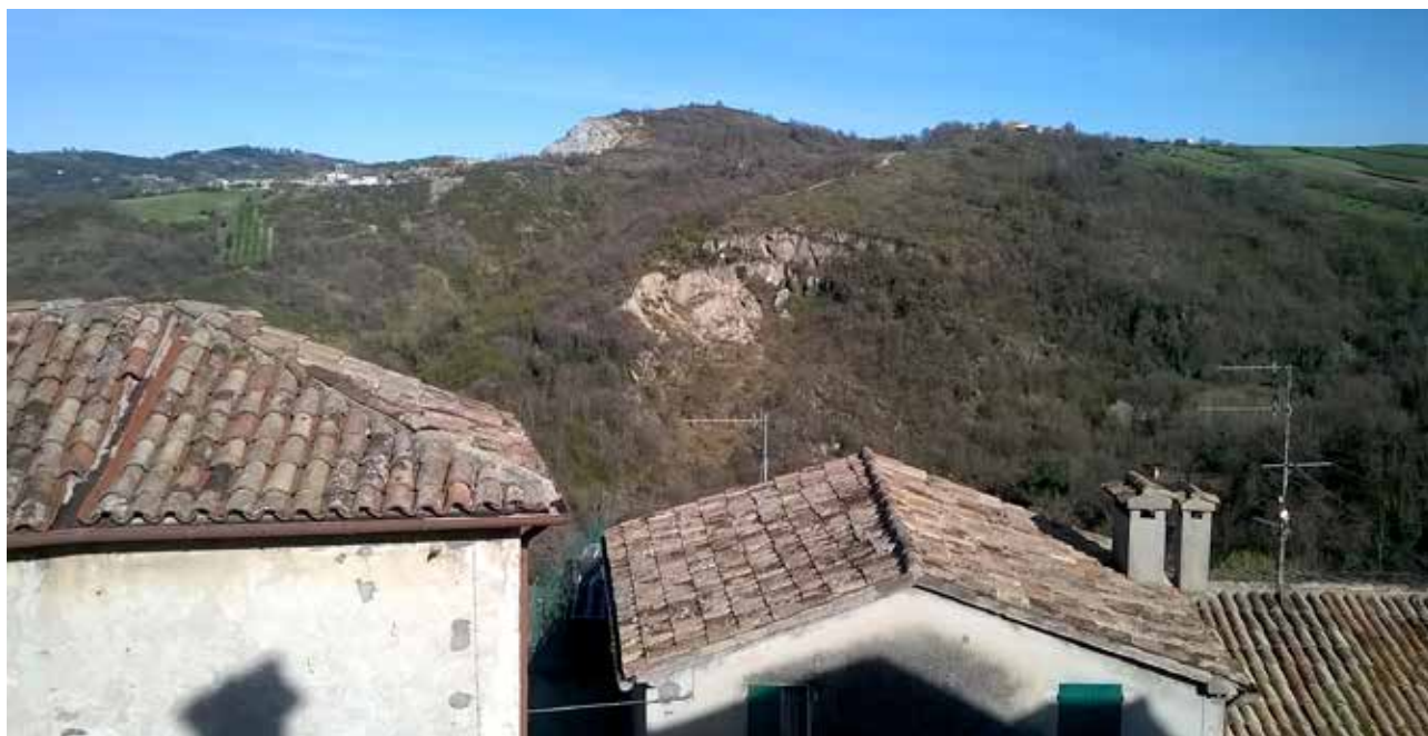
Fig. 22 – L'ex cava di gesso in località "Sibe"/"Desside"/"Tessite", in destra Rio Marano in territorio sammarinese, ai nostri giorni, fotografata da Montegiardino. Il confine di stato fra San Marino e Italia qui corre sul ciglio dell'anfiteatro estrattivo. Nel Novecento, la cava fu condotta dalla famiglia Pasquali; i lavori si conclusero nel 1957-1958. Sullo sfondo, sulla sinistra dell'immagine, è visibile la cava di Ca' Budrio (Gesso di Sassofeltrio), in territorio italiano, tuttora attiva (foto S. Piastra).
