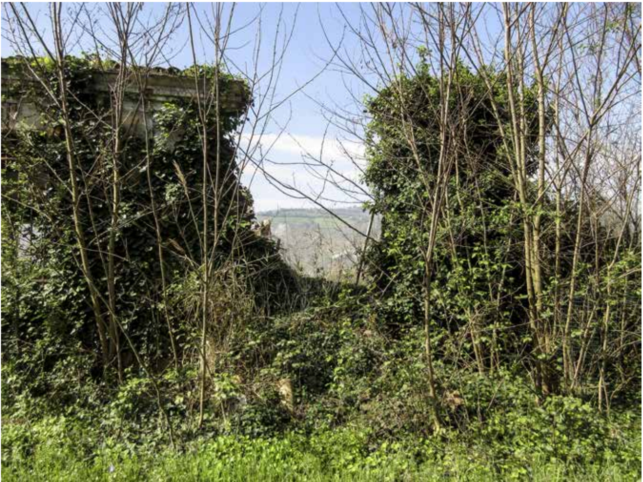
Fig. 7 – Formignano. Uffici; crollo del tetto, 2016 (Archivio SRSRM).
