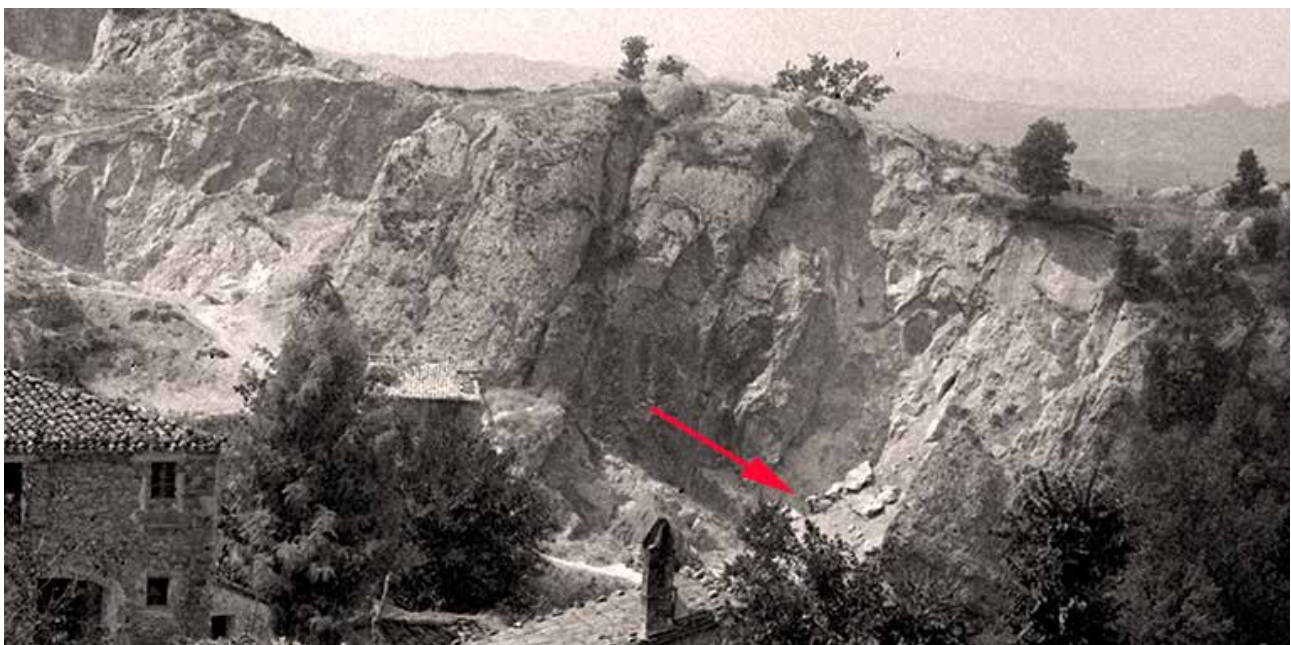
Fig. 10 – Particolare di fig. 9: la freccia indica un "gessarolo" chino, intento a lavorare; sopra di lui, la stabilità del fronte estrattivo appare in condizioni di sicurezza critiche.
