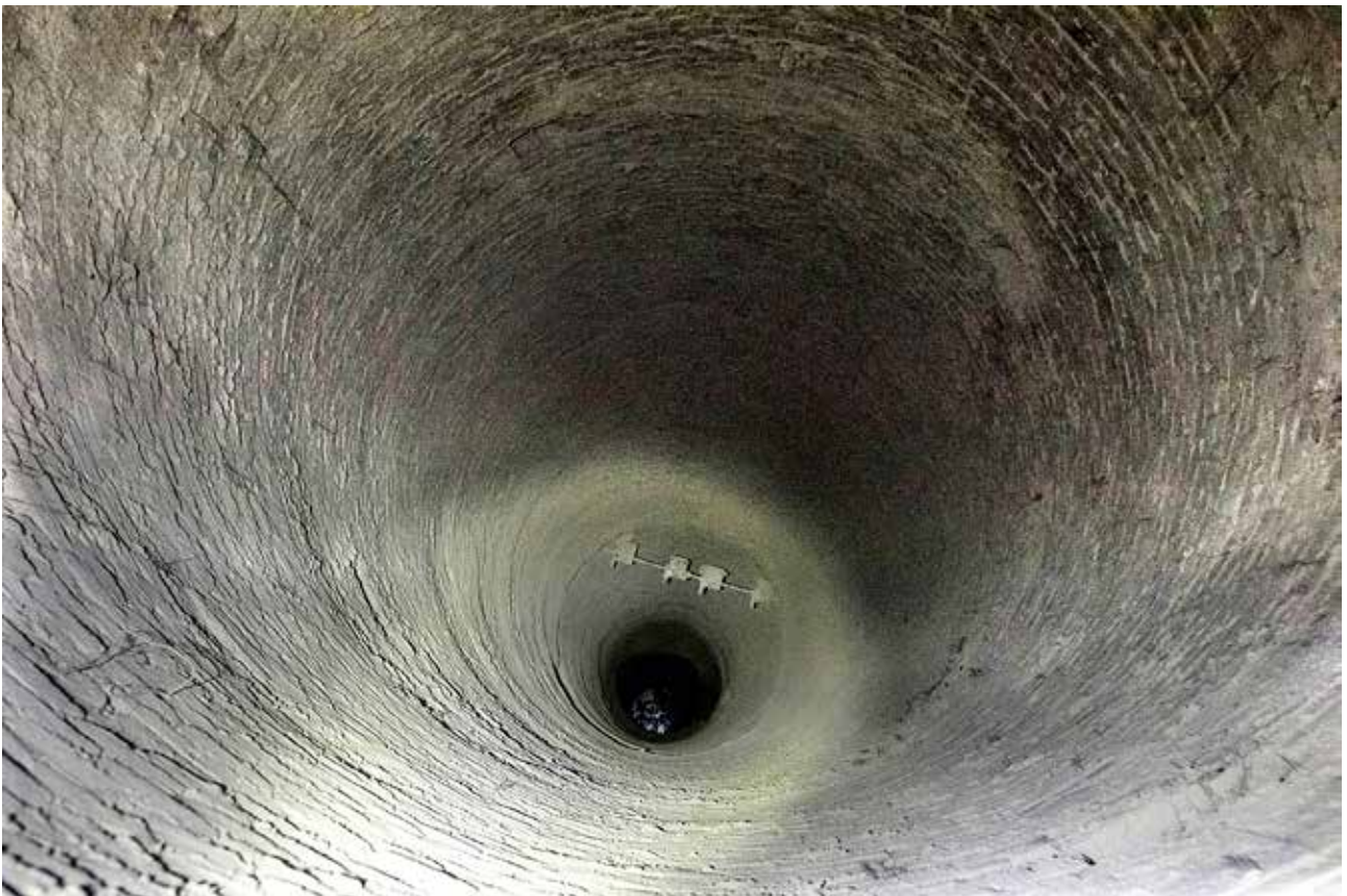
Fig. 40 – Canna del Pozzo Montemauro Vecchio: è visibile il supporto del pianerottolo (foto M.L. Garberi).
