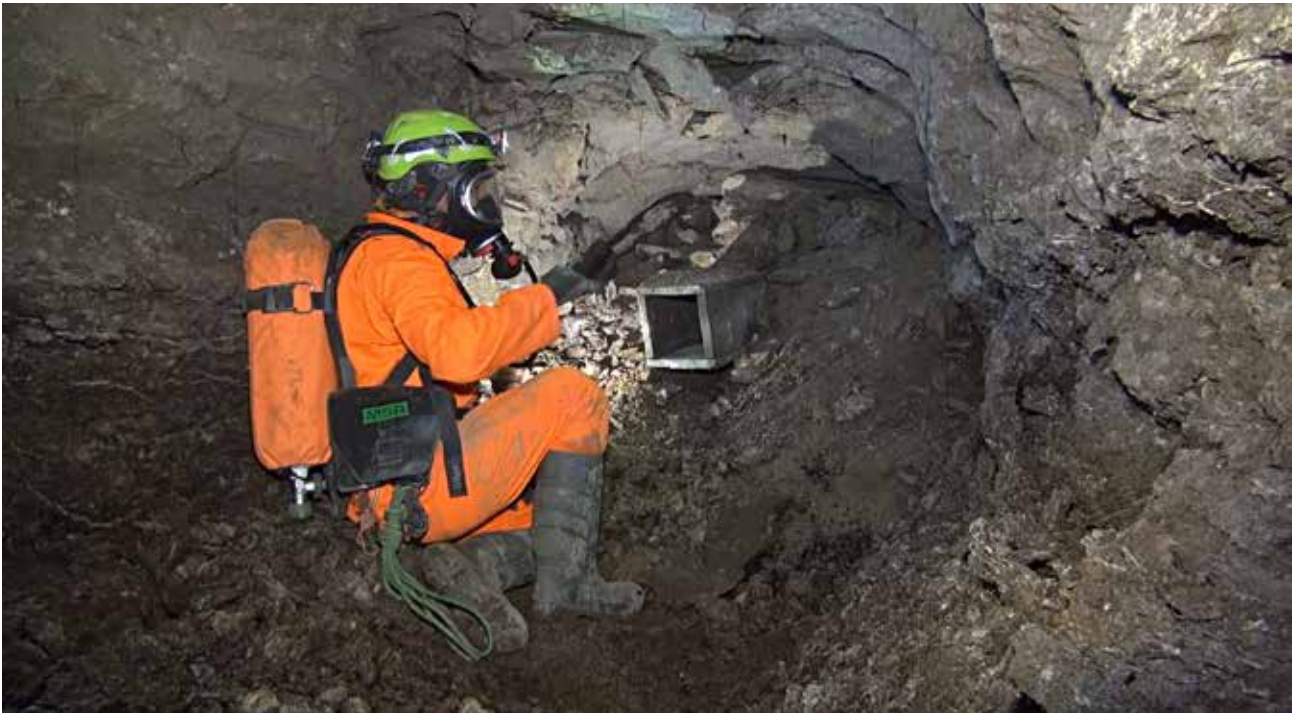
Fig. 51 – Sbarramento artificiale, attraversato da un probabile condotto di areazione (fotogramma video M.L. Garberi).
