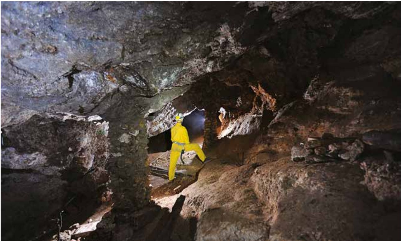
Fig. 3 – Consolidamenti all'interno della Solfatara di Predappio Alta (foto G. Belvederi).
