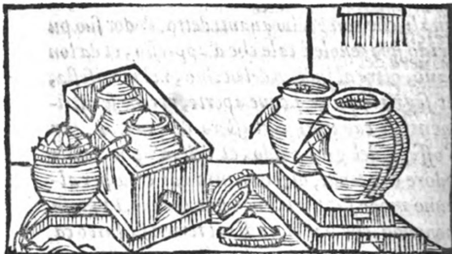
Fig. 2 – Distillazione dello zolfo in un'incisione da un'edizione successiva della Pirotechnia di Biringuccio (BIRINGUCCIO 1559). Rispetto alla raffigurazione della I edizione dell'opera, la qualità è inferiore e la prospettiva resa specularmente, probabilmente in seguito alla realizzazione di una nuova matrice intagliata ricopiando "in positivo" l'illustrazione dell'edizione originale.
