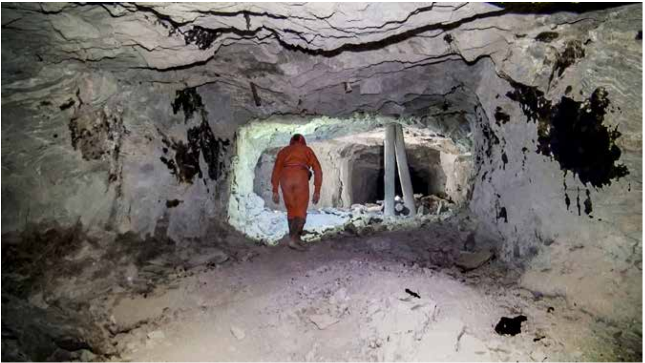
Fig. 5 – Colate di bitume dalle pareti delle gallerie (fotogramma video M.L. Garberi).
