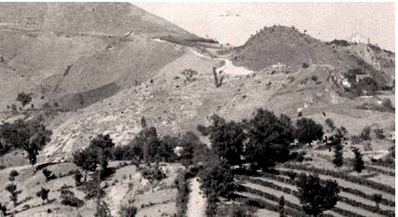
Fig. 12 – Particolare di fig. 11: si nota l'affioramento gessoso di Montebello prima dell'approfondimento dei lavori; sulla destra, ai bordi di una strada, si distingue il profilo di un fronte estrattivo in avanzamento.
