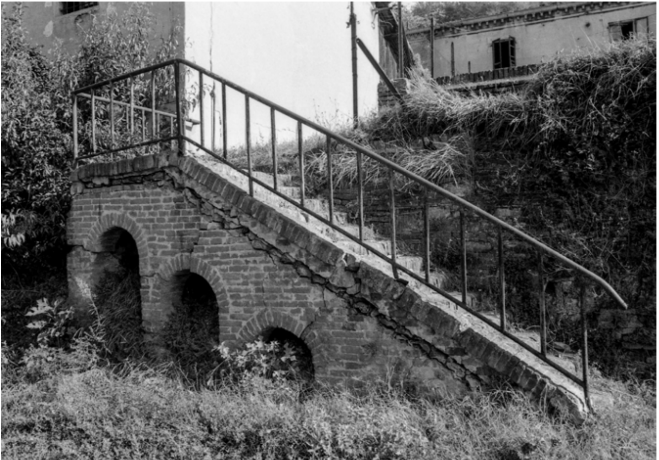
Fig. 9 – Formignano. Scala centrale, 1989 (Archivio SRSRM).
