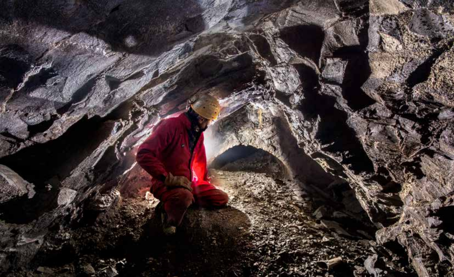
Fig. 9 – Montecatini, “Galleria Dellamore”: l’ipogeo artificiale è percorribile seguendo il vuoto creatosi nella parte superiore della galleria, in gran parte crollata (foto P. Lucci).
