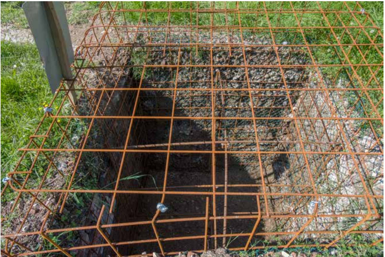
Fig. 25 – Scavo del Pozzo Alessandro (foto G. Belvederi).
