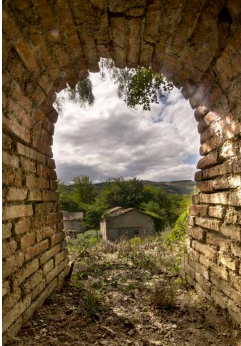
Fig. 24 – Galleria dell'acqua (foto P. Lucci).
