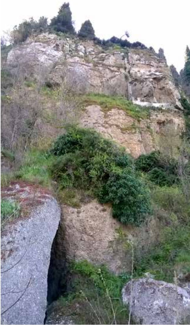
Fig. 19 – Le “Ripe” di Faetano oggi: lavori di consolidamento della parete gessosa. In primo piano è visibile una piccola cavità di crollo, in passato usata verosimilmente per scopi pastorali (foto S. Piastra).
