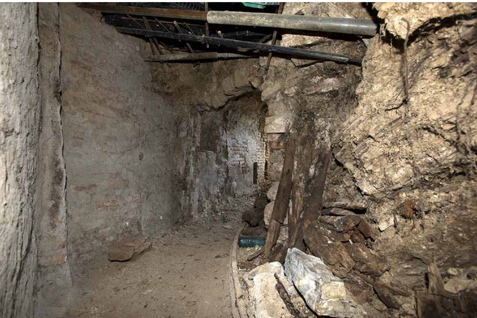
Fig. 33 – Galleria di servizio del Tiro Confine (foto G. Belvederi).
