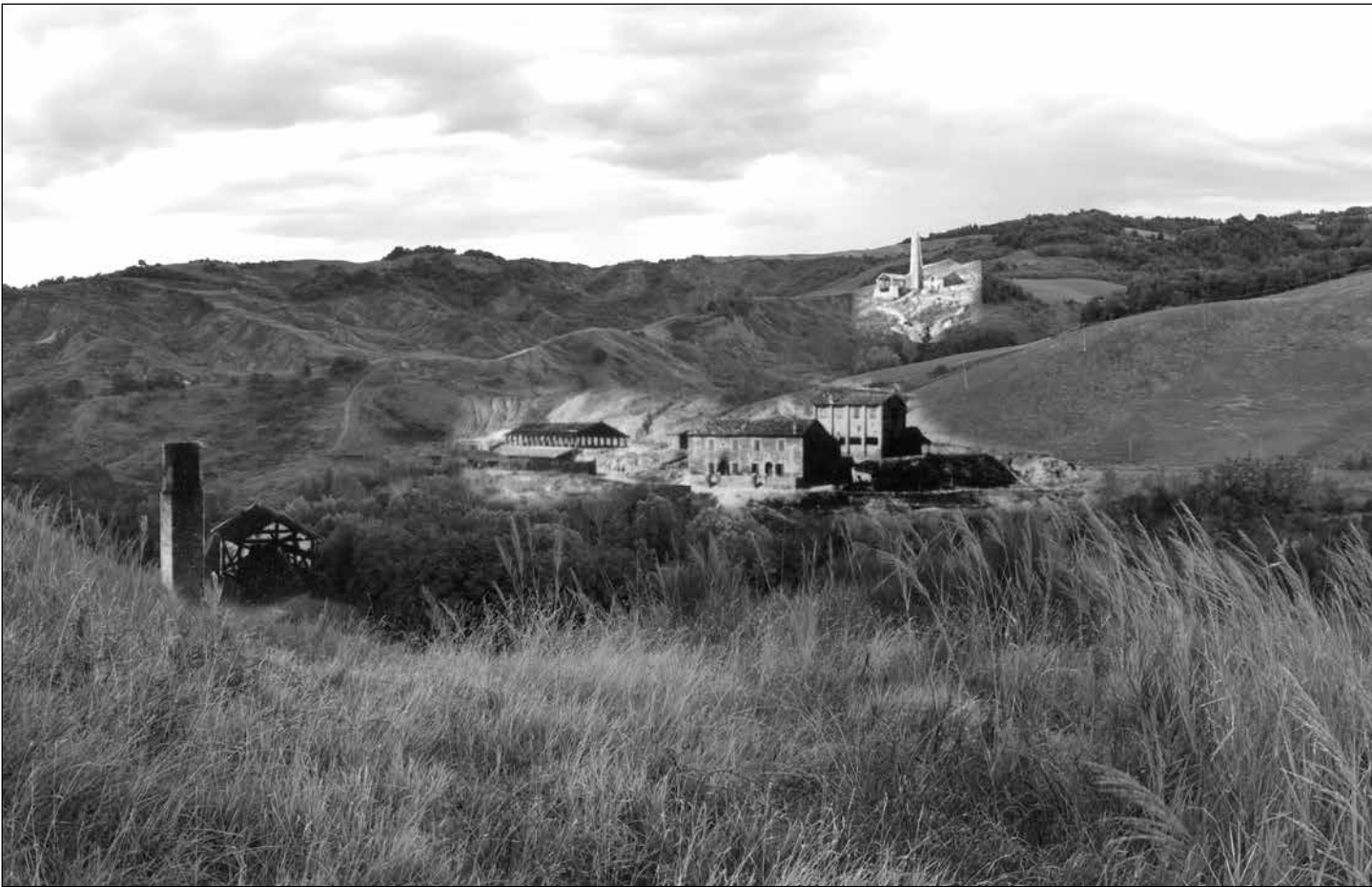
Fig. 10 – Foto attuale con posizionamento di elementi della foto ottocentesca (elaborazione G. Belvederi).
