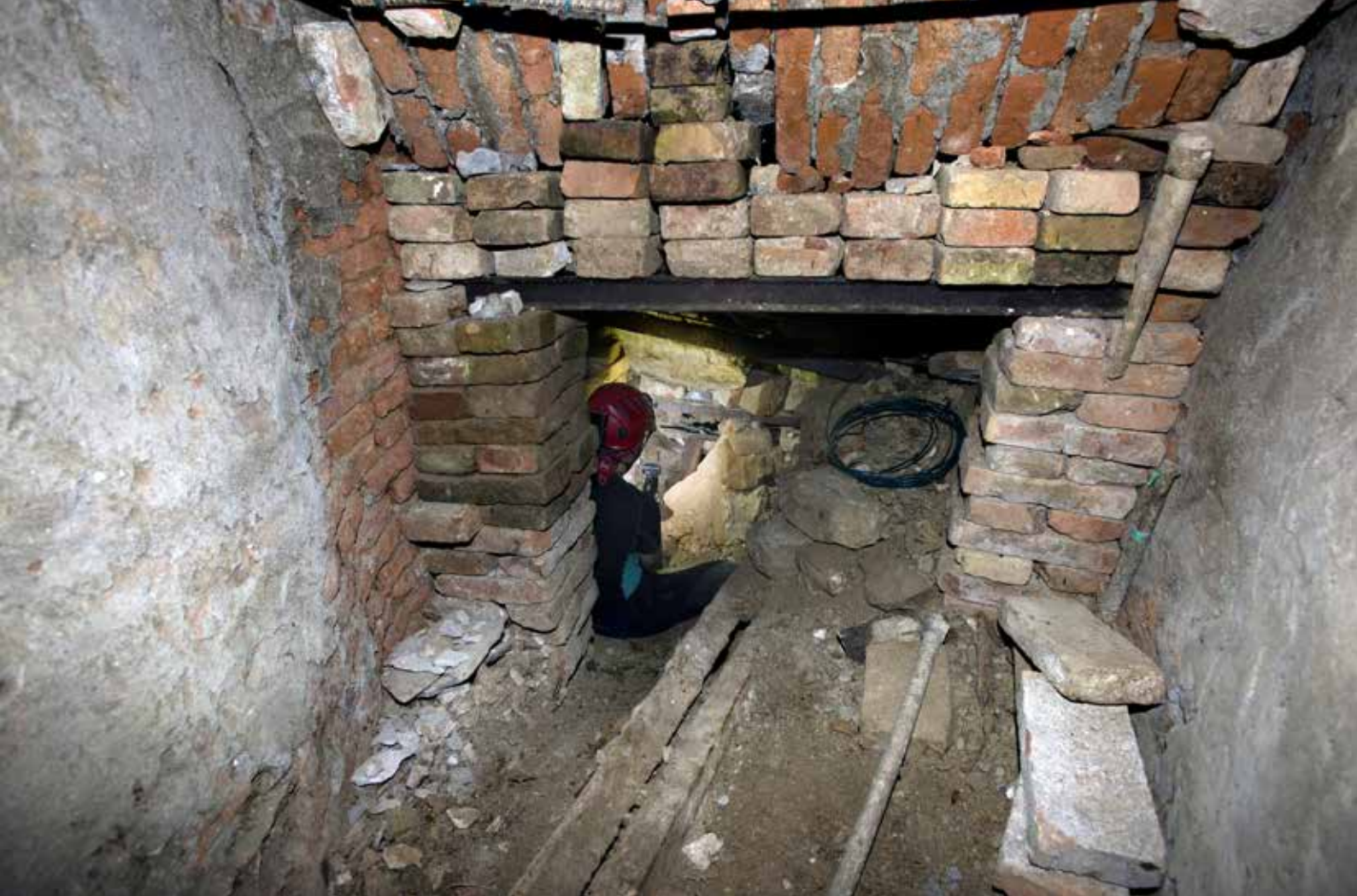
Fig. 34 – Galleria di aerazione del Tiro Confine (foto G. Belvederi).
