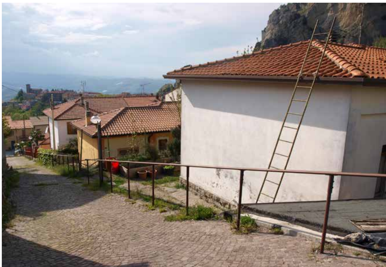
Fig. 38 – Perticara: il "Villaggio Costanzo Ciano", costruito alla fine degli anni Trenta del Novecento nel periodo di gestione Montecatini e intitolato al padre del genero del Duce. L'edilizia realizzata era ispirata a criteri di serialità e modularità (foto S. Piastra).
