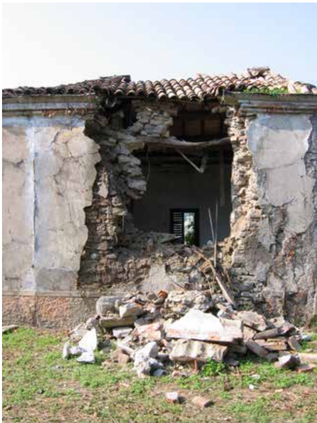
Fig. 6 – Formignano. Uffici; crolli di pareti, 2005 (Archivio SRSRM).
