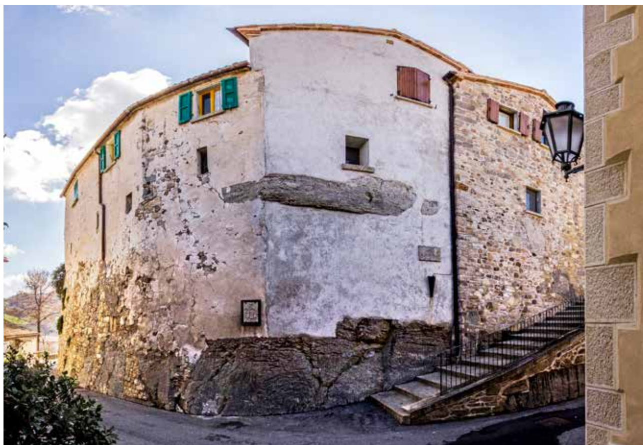
Fig. 11 – Edilizia urbana di Montegiardino, fondata sul gesso e che letteralmente ingloba parti del substrato selenitico nelle murature (foto P. Lucci).
