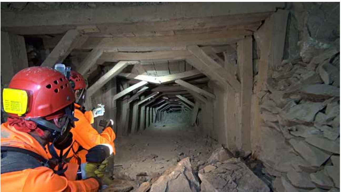
Fig. 56 – Galleria verso il Pozzo Montecchio con armatura pericolante (fotogramma video M.L. Garberi).
