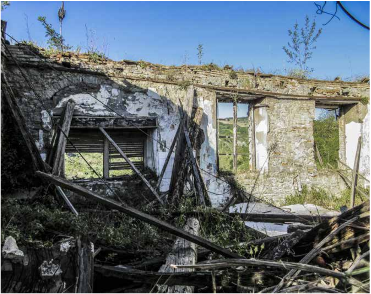
Fig. 8 – Formignano. Interno ufficio, 2016 (Archivio SRSRM).
