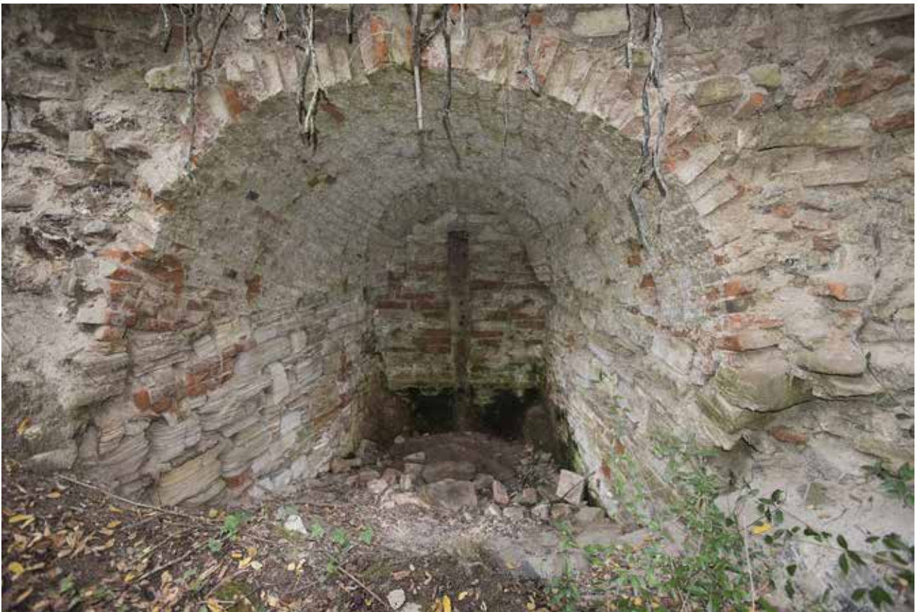
Fig. 15 – Bocca di un calcarone della miniera Boratella 3, lastra di cotto con i fori per far uscire il solfo fuso (foto G. Belvederi).
