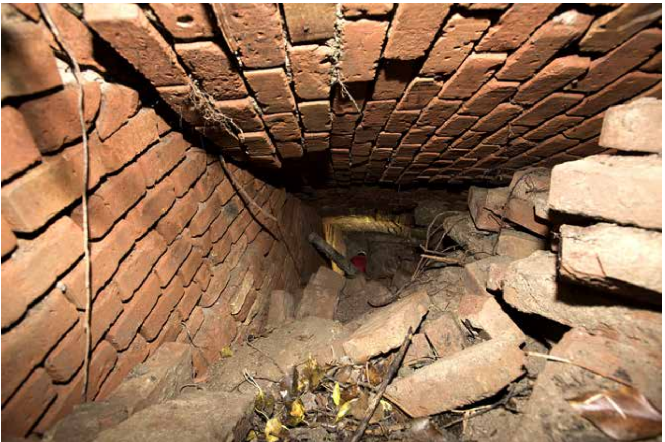
Fig. 36 – Galleria di aerazione del Tiro Busca (foto G. Belvederi).
