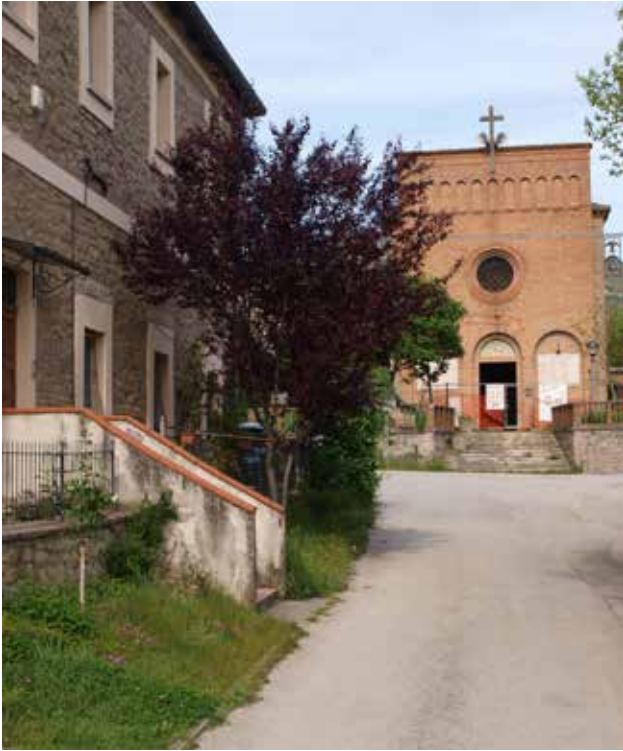
Fig. 37 – Miniera di Peticara (Novafeltria): sulla sinistra, edifici in pietra risalenti al XIX secolo all'epoca della gestione della solfatara da parte della Società delle Miniere Zolfuree di Romagna; sullo sfondo, la chiesa intitolata a S. Barbara, protettrice dei minatori, costruita negli anni Cinquanta del Novecento al tempo della gestione Montecatini (foto S. Piastra).
