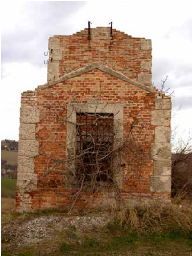
Fig. 4 – Miniera di S. Apollinare (Meldola): la cabina elettrica oggi (foto S. Piastra).
