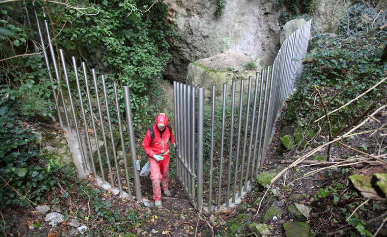
Fig. 2 – Chiusura dell'ingresso superiore della Grotta di Onferno (ER RN 456) realizzata nell'ambito del Progetto Life+ "Gypsum" (archivio Life+ 08/NAT/IT/369 "Gypsum", foto F. Grazioli).
