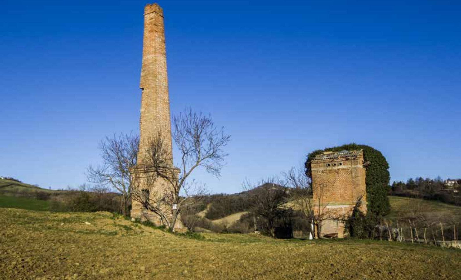
Fig. 42 – Cabina elettrica e camino della macchina a vapore per l'argano a Luzzena (foto P. Lucci).
