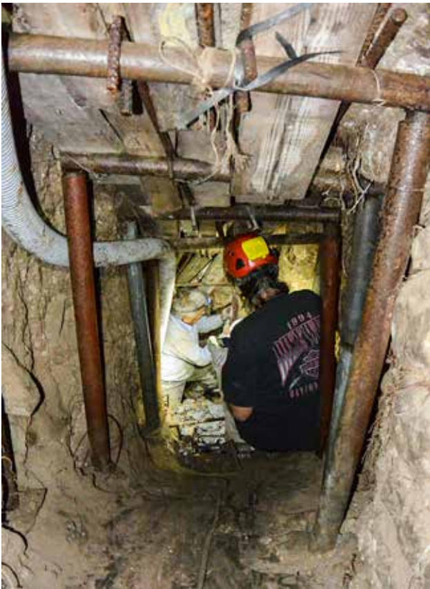
Fig. 58 – “Le Scale”, lavori di disostruzione. A sinistra è visibile il tubo per la ventilazione forzata (foto M.L. Garberi).
