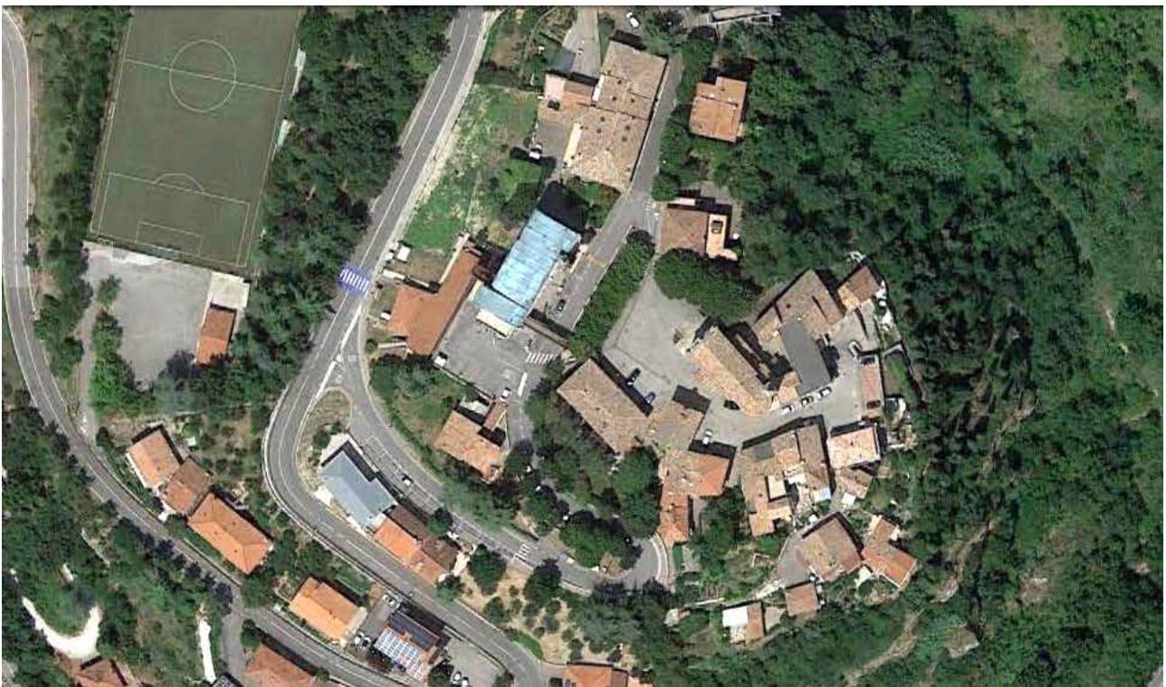
Fig. 17 – Faetano oggi: interventi recenti hanno cancellato gran parte dell'edilizia storica; l'attuale chiesa di San Paolo è stata ricostruita in stile neo-gotico nel 1916, ruotando di quasi 90° l'orientamento dell'edificio rispetto a quello originario (fonte: GoogleEarth).
