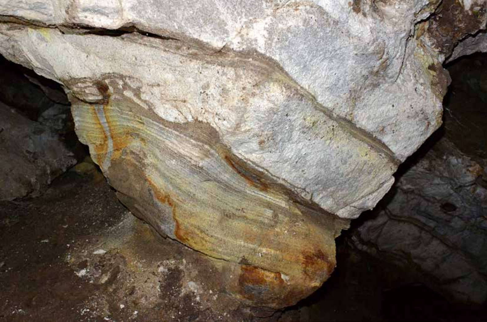
Fig. 8 – Pilastro strutturale del primo vuoto di coltivazione (foto G. Belvederi).
