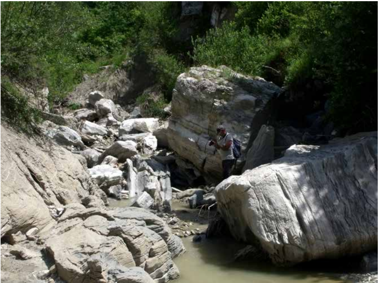
Fig. 12 – Medio corso del Torrente Fanantello, il letto del torrente è per buona parte ingombro da massi e detriti, manca spazio per la vegetazione ripariale (foto S. Montanari).
