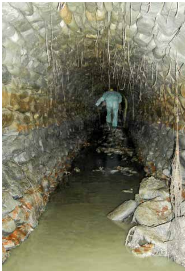
Fig. 6 – Linaro (Mercato Saraceno), località Ca' di Gallo e Casetto. Breve galleria, forse legata allo scolo delle acque della locale solfatara, di cronologia imprecisata (foto S. Gonnella).
