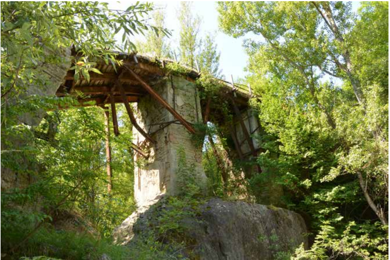
Fig. 60 – Ponte sul Torrente Fanantello (foto G. Belvederi).
