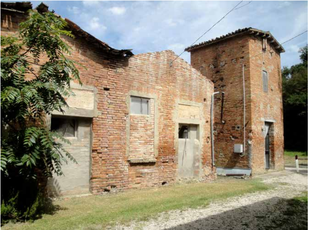
Fig. 2 – Strutture della miniera di zolfo di Rio Paladino (Meldola) ai nostri giorni. Sulla destra, è visibile la cabina elettrica, risalente all'ultima fase di attività del sito (foto W. Formella).
