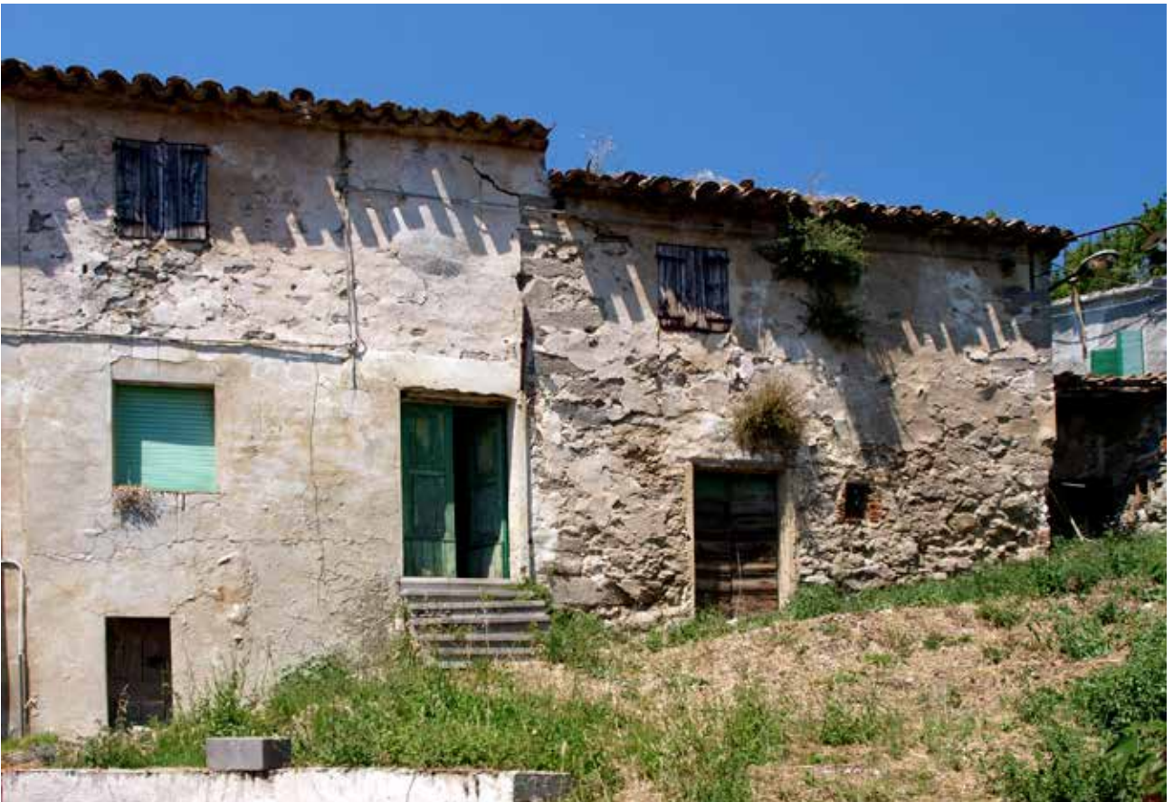
Fig. 21 – Edilizia storica abbandonata in selenite presso Gesso (Sassofeltrio, PU) (foto S. Piastra).
