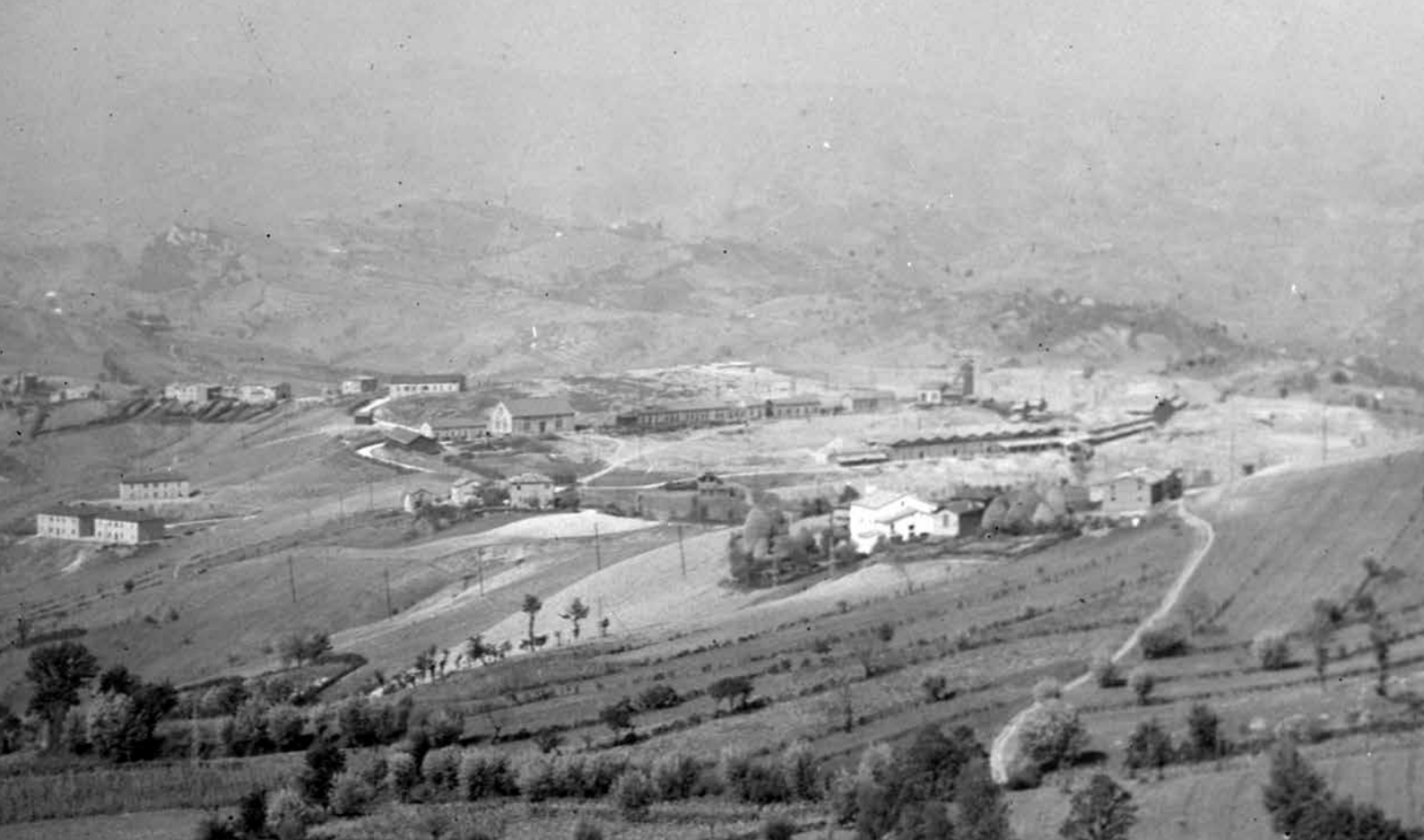
Fig. 52 – Ingrandimento di fig. 51: il cantiere Certino.
