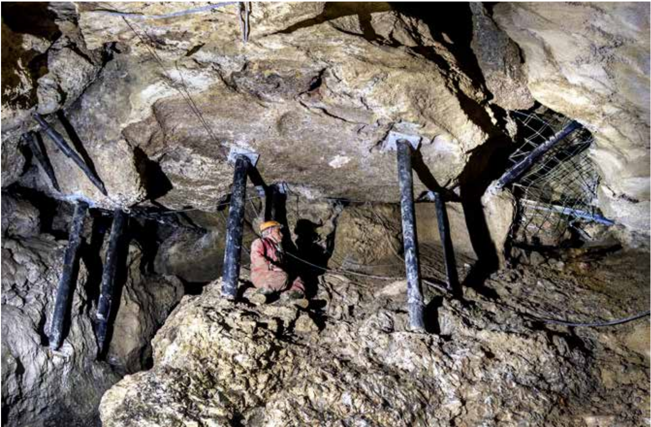
Fig. 62 – Invadenti strutture di consolidamento e cavi elettrici nel tratto turistico della Grotta di Onferno (foto P. Lucci).
